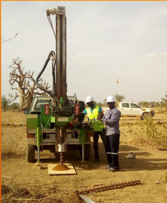
Forage mototarière sur le projet Bogandé, Essakane
